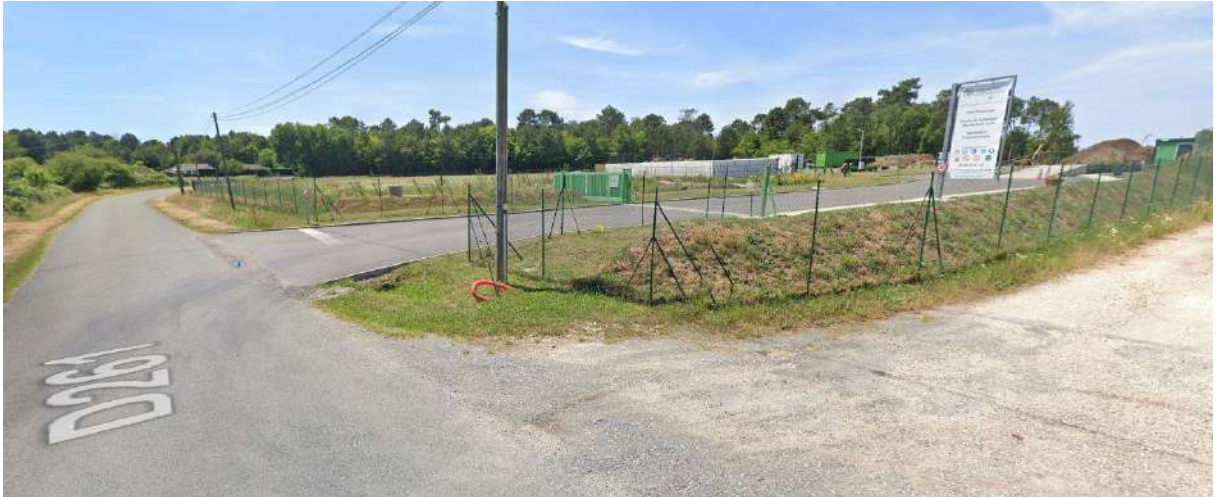
Entrée sur le site du pôle recyclage depuis la RD 261, direction Lapouyade
