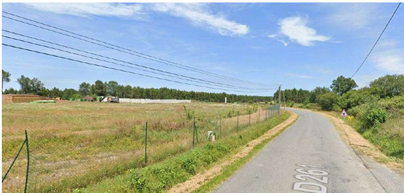
RD 261, direction centre-bourg, avec pôle recyclage sur la gauche
